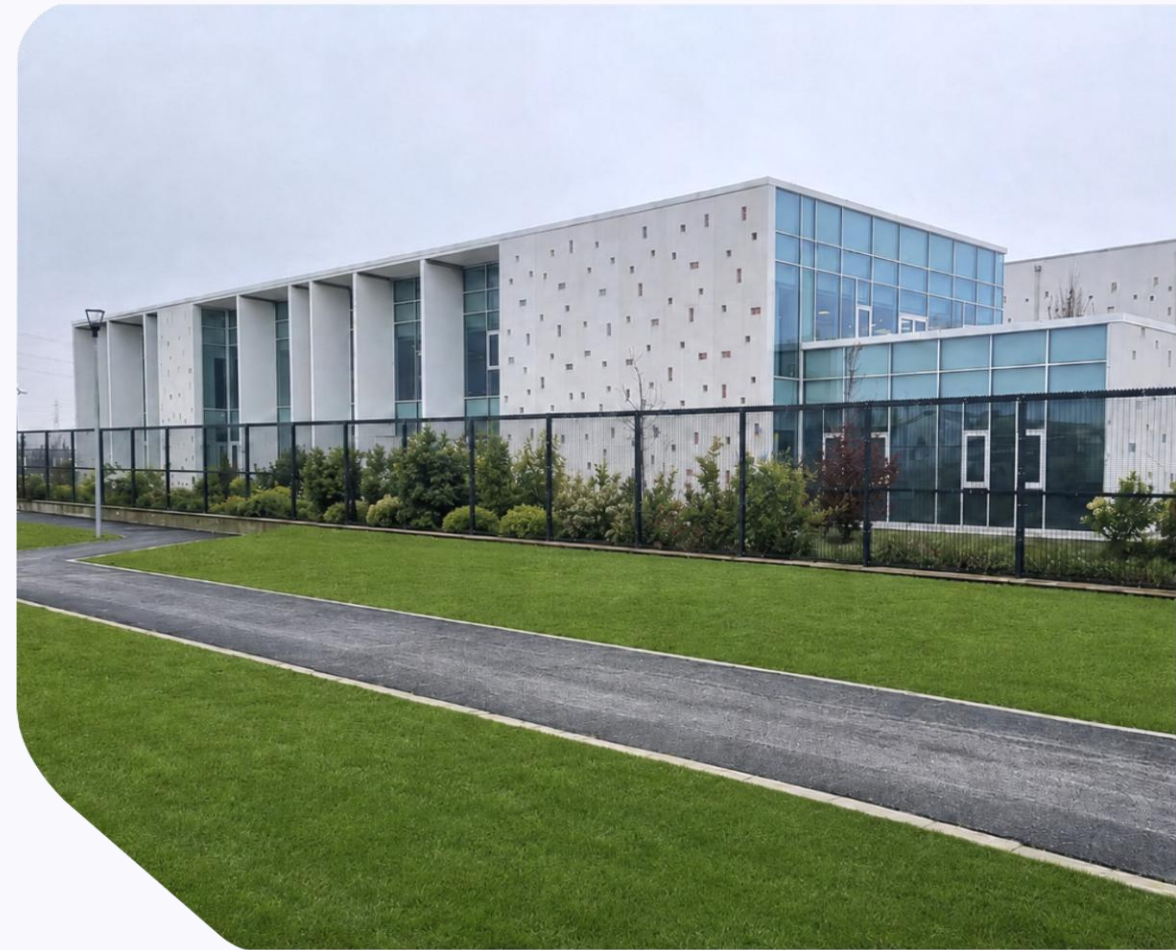
TIM, Data Center –Settimo Torinese
